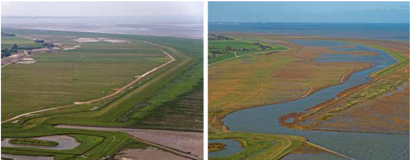
Abbildung 6.23: Renaturierungsmaßnahme Langwarder Groden. Das linke Foto zeigt den Langwarder Groden vor der Maßnahmenumsetzung im Jahr 2013 (Foto N. Hecker, NLPV). Rechts sieht man den gleichen Küstenabschnitt im Jahr 2018, vier Jahre nach der Maßnahmenumsetzung (Foto N. Hecker, NLVP).
