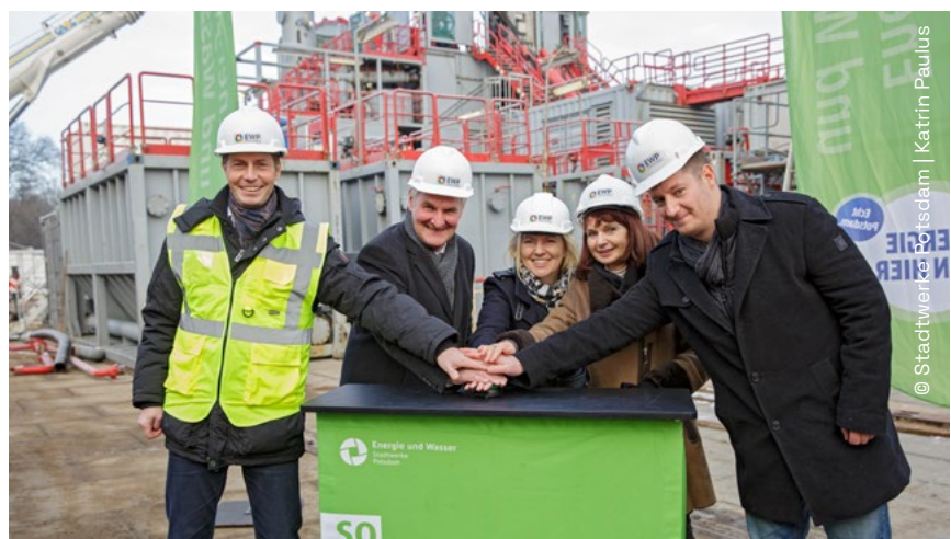
Symbolischer Start der Bohrungen für die Tiefengeothermie in Potsdam im Dezember 2022
