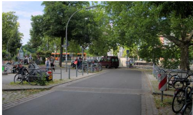
E.2 Anhebung zur Temporeduktion vor einem Schuleingang mit starkem Querungsbedarf von Menschen zu Fuß. Weichselstraße, Berlin Friedrichshain-Kreuzberg.
