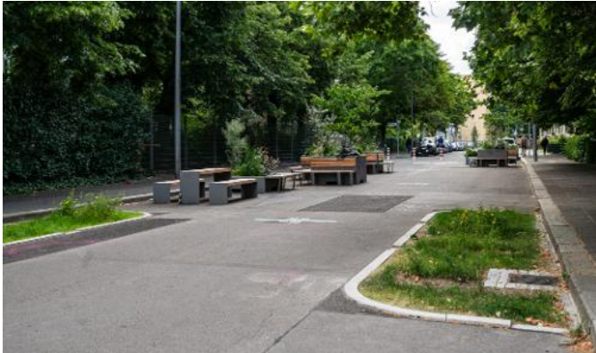
C.1 Grüner Gully als flexibel einsetzbare Maßnahme für deutlich mehr Versickerung bei versiegelten Straßenflächen. Oberflächenabflusswasser versickert im Regelfall, nur bei Starkregen fließt überschüssiges Wasser über den Gully ab. Singerstraße, Berlin-Mitte.
